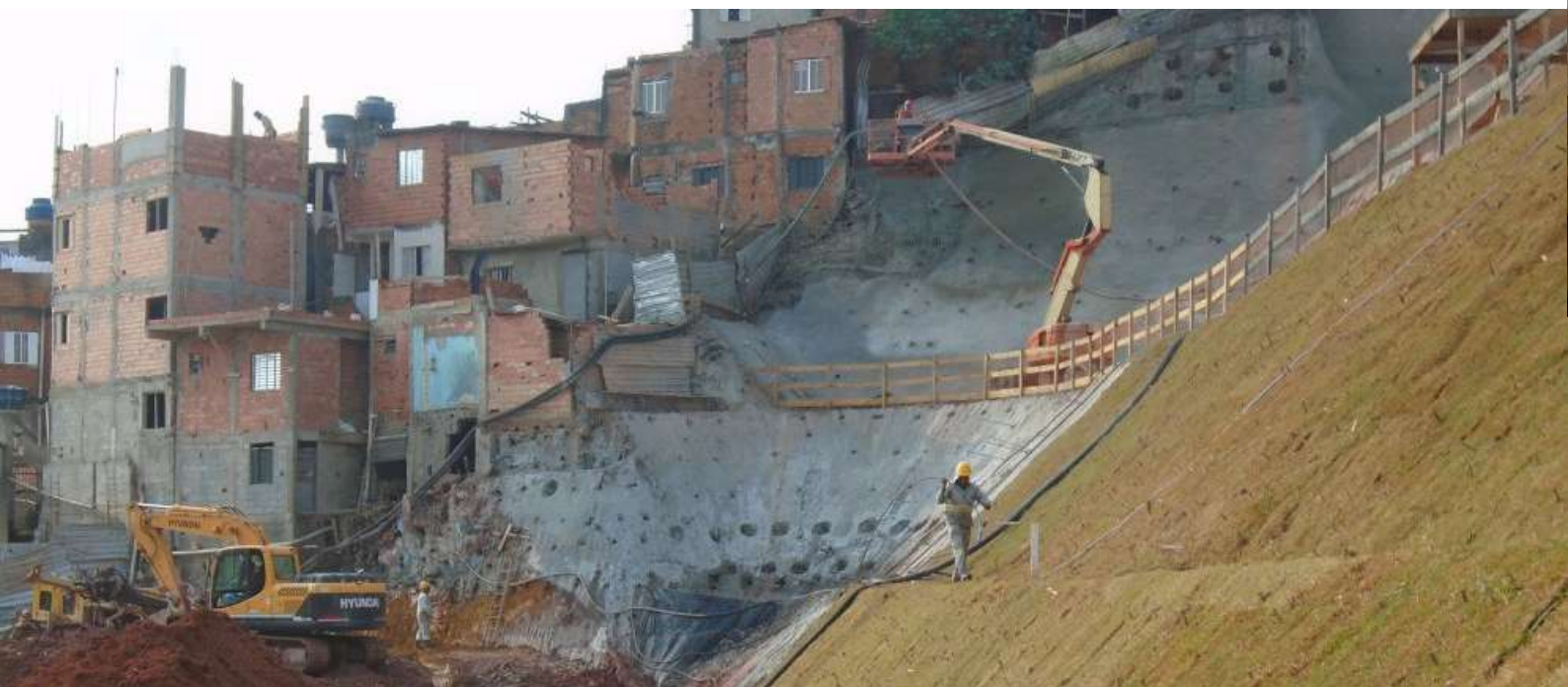
Fig. 013 e 014 - Obras de Infraestrutura realizadas no Parque do Sanfona.
